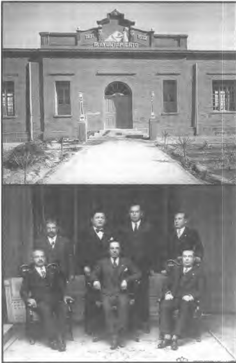
Se construyó este moderno establecimiento de salud mediante el esfuerzo del H. Ayuntamiento de 1931-32.
